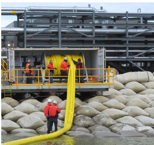
Foto 3: Lançamento de Barreiras de Contenção
