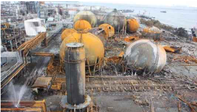
Figura 6: Danos na área industrial no Japão em 2011.
