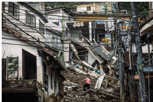
Figura 3. Lama e escombros que tomaram a Servidão Frei Leão, principal ladeira de acesso à comunidade, em Petrópolis (2022) Foto: Lucas Ninno (Ref. 7).
