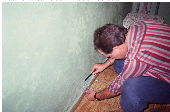
Foto 02 - Raspagem das paredes.
