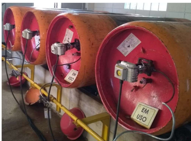
Foto 01 - Cilindros de Cloro;
