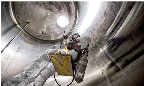
Foto: Respirador de linha de ar comprimido de demanda com pressão positiva, com peça facial inteira, combinado com cilindro auxiliar para fuga.
