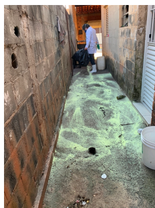
Foto 4 - Aplicação de enxofre em pó para neutralização de mercúrio metálico.
