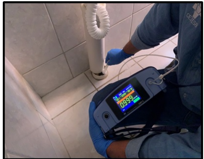
Foto 6 - Sistema hidráulico de residência contaminado por mercúrio.
