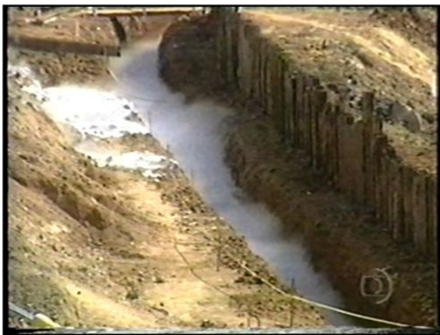
Figura 2: Condensação da umidade provocada pela nuvem de GLP no Córrego Vermelho.
