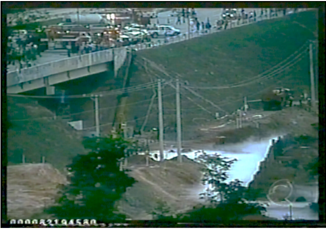
Figura 3: Posicionamento equivocado do Posto de Comando.
