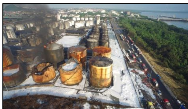
Incêndio em área de tanagem – Santos, SP (abril/2015)
